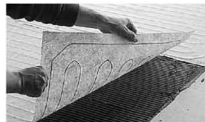
I6. Lay down WTE mat
