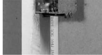
Figure N8. Conduit installation
